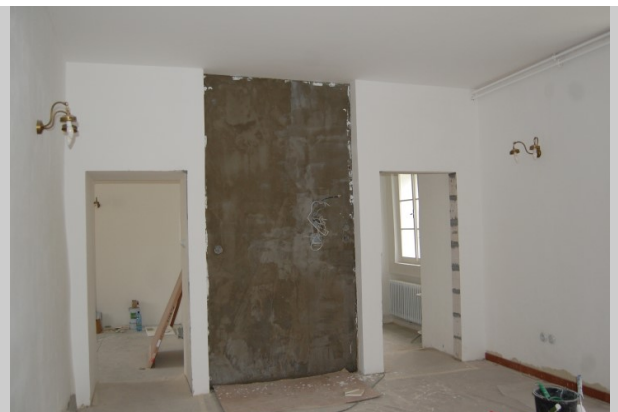
Předzámčí – průběh rekonstrukce apartmánu
