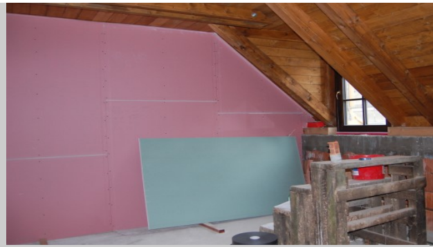
Příprava interiéru - podkroví
